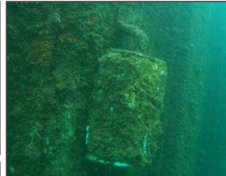
鋼矢板の陽極取り付け状況
