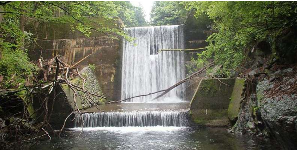
砂防施設点検
