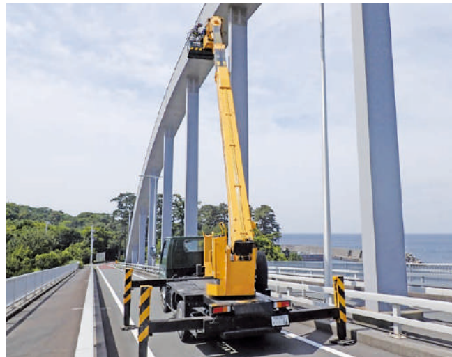
橋梁点検(高所作業車)
