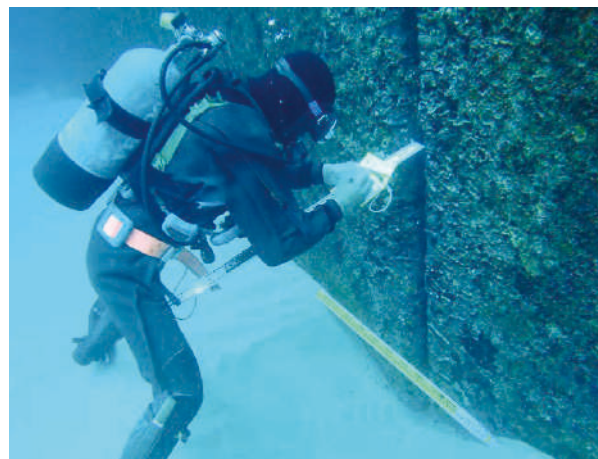
港湾構造物調査(潜水調査)
