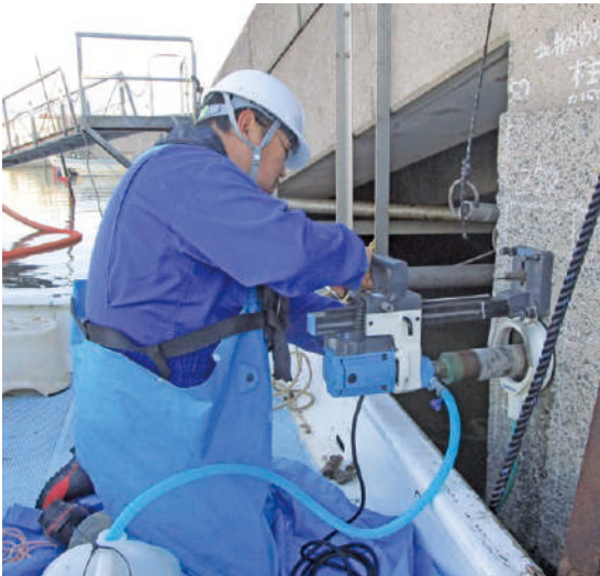
漁港施設機能診断(詳細調査)
