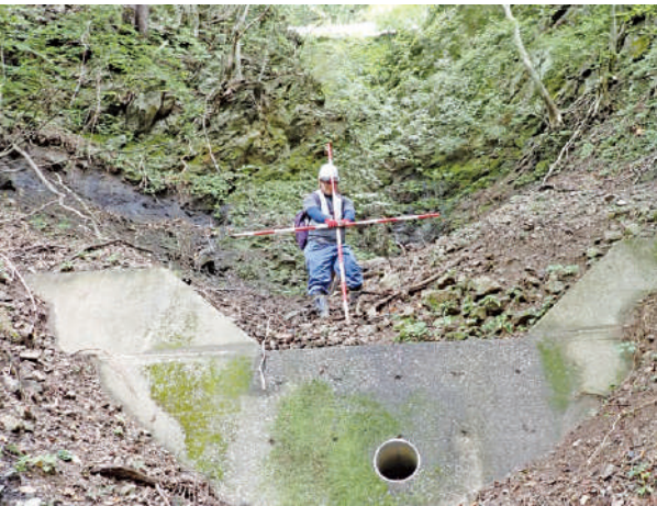
治山施設点検
