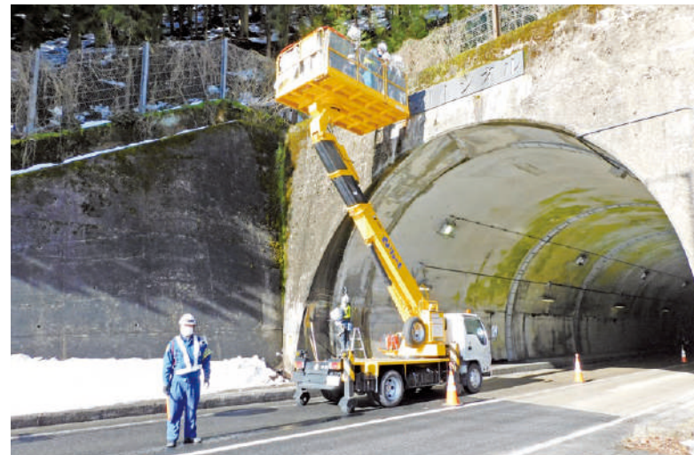
トンネル点検(トンネル点検車)
