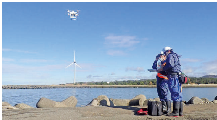
港湾構造物調査(UAV)
