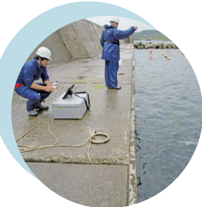
漁港施設点検(水中ドローン)
