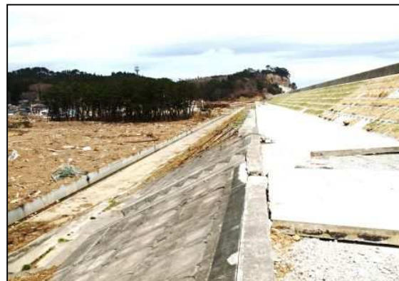
写真5 破壊された防波堤背面
