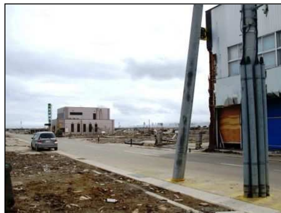
写真4 背後の被害状況
