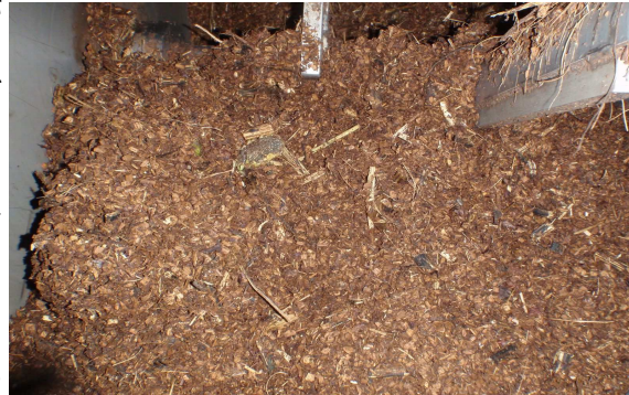
高温好気発酵分解 （発酵槽内部）
