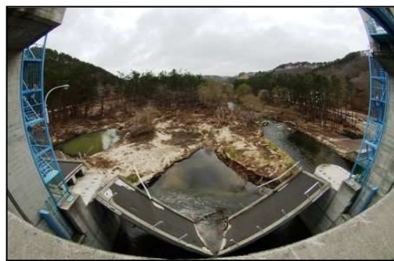
写真2 水門背後の管理道路
