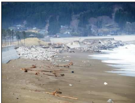
写真3 崩壊した防波堤
