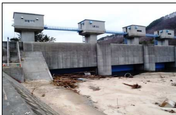
写真1 普代川河口水門
