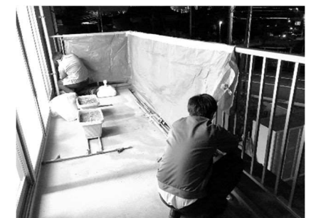
避難所となった施設のベランダに目隠し実施
